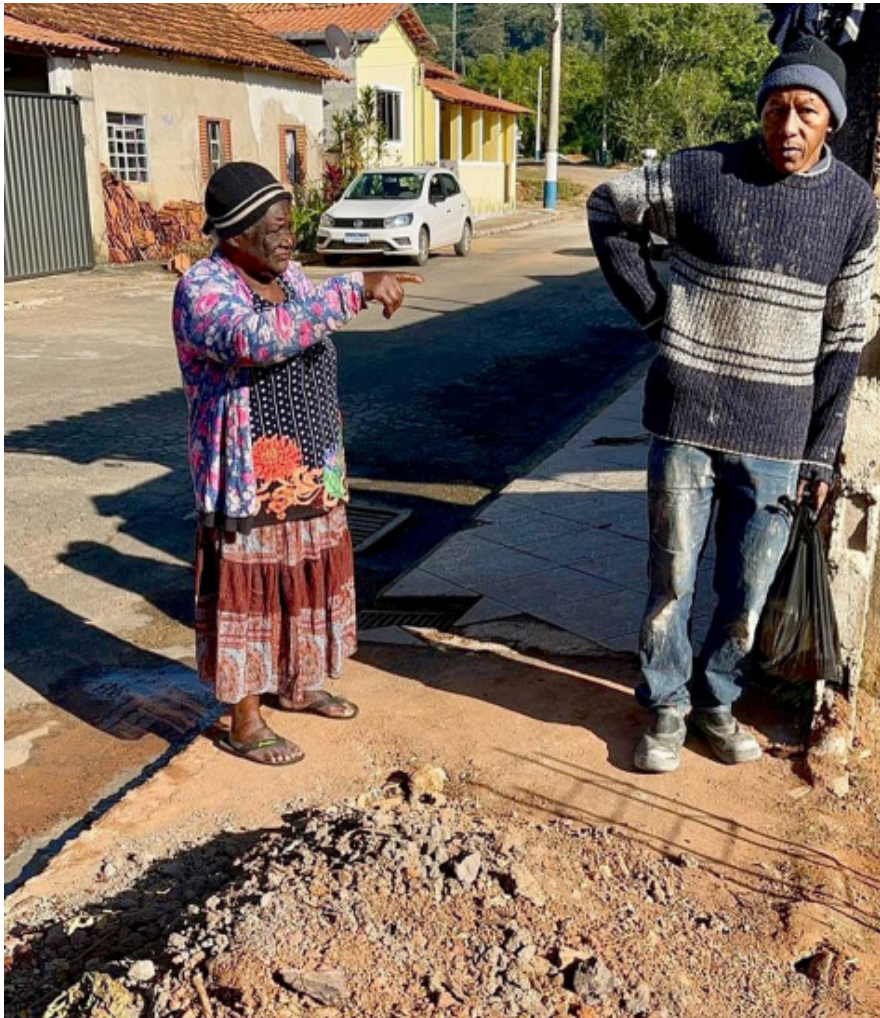
Dona Geralda durante os trabalhos da concretagem Página 8
