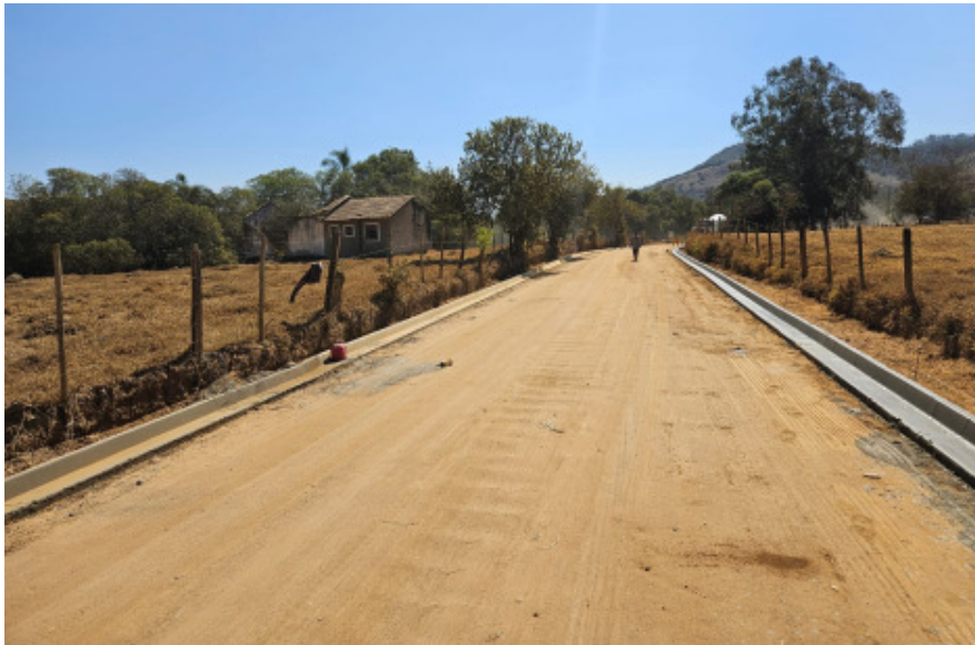
Início do calçamento na estrada do Sertãozinho
