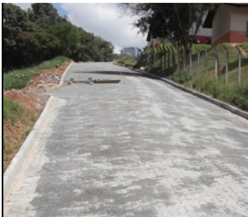
Calçamento ao lado da Escola
