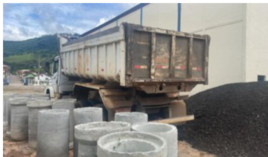
Fresas Asfálticas em Senador José Bento
