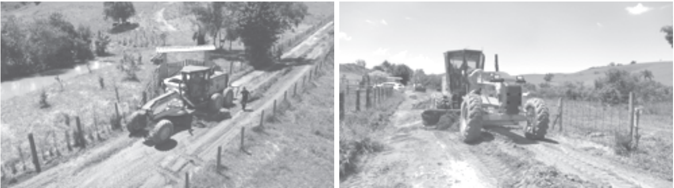
A Prefeitura de Borda da Mata, através da Secretaria de Obras, concluiu no final de janeiro os reparos e cascalhamento de trechos da estrada do Bairro Fartura. A administração tem se empenhado em realizar intenso trabalho de revitalização nas estradas rurais em todo o município, garantindo mais segurança e comodidade para os moradores.
