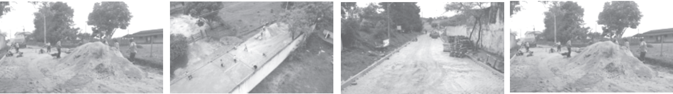
A Prefeitura de Borda da Mata anuncia mais uma obra de pavimentação iniciada pela Secretaria de Obras. Desta vez, é a extensão do calçamento da Rua Demercindo da Costa Brandão, no bairro Nova Borda, que está sendo revitalizada com bloquetes, trecho que antes era de terra.
