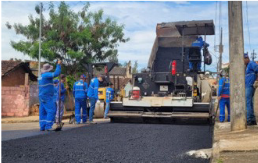
Rua do Distrito do Cervo recebendo asfalto
