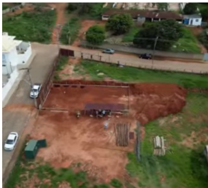
Início das obras da nova UBS
