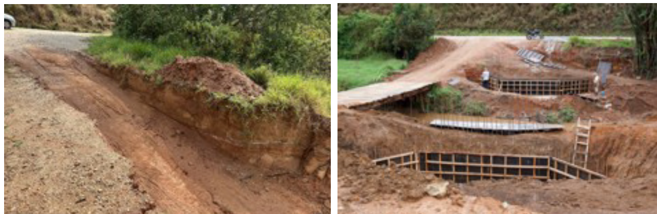
Reconstrução das pontes de acesso das comunidades Capinzal e Pitangueiras
