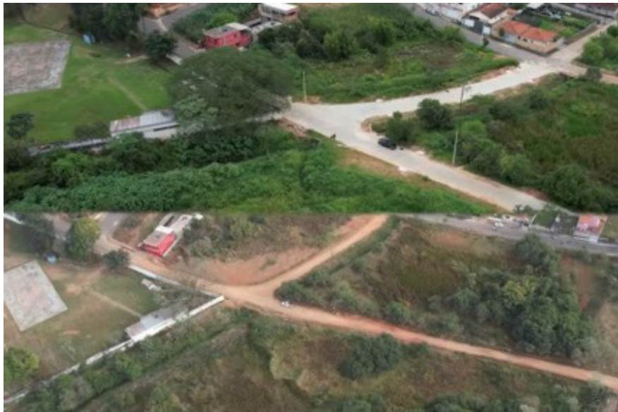
Ruas calçadas no Bairro Santa Rita
