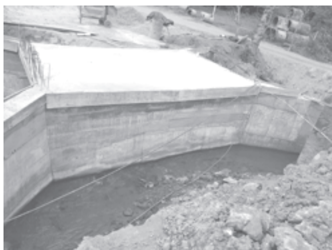
Ponte no Bairro Capinzal
