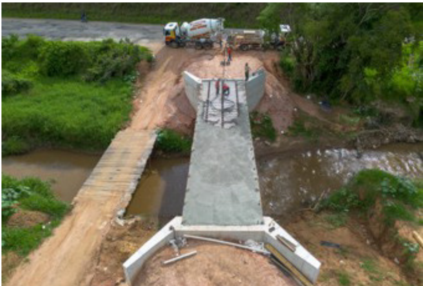
Concretagem na Ponte do Freitas em Tocos do Moji
