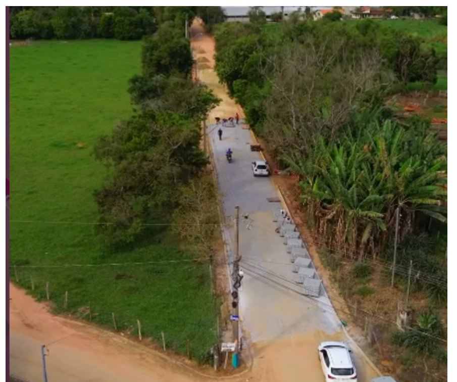
Calçamento no Bairro Santa Cruz
